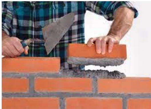
**Figure II.2 : Monter un mur en brique (18)**
