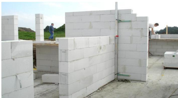
Figure II.2; siporex ou béton cellulaire(1)
