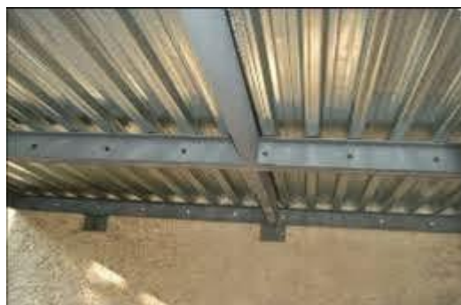
Figure I.7 : Planchers en acier
