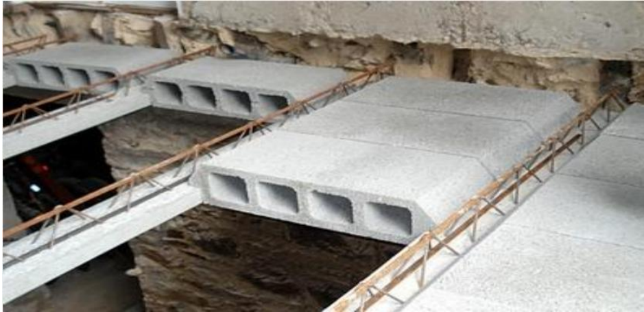
Figure I.18 : mise en place les hourdis.
