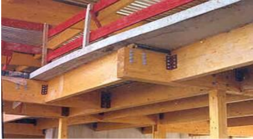
Figure I.40 : plancher mixte béton armé/ bois
