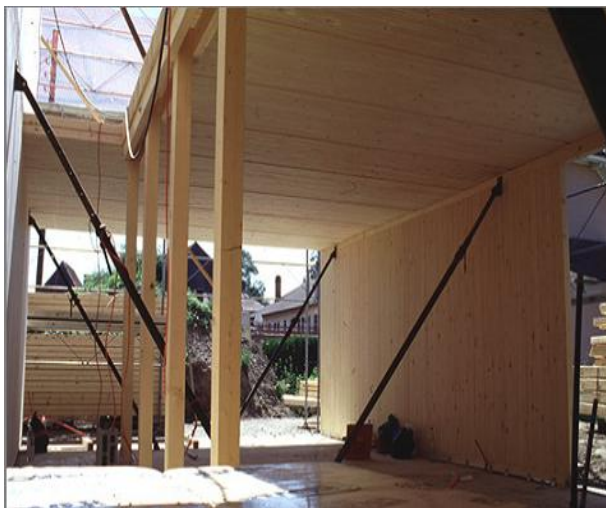
Figure I.37 : Appuis sur mur en ossature bois
