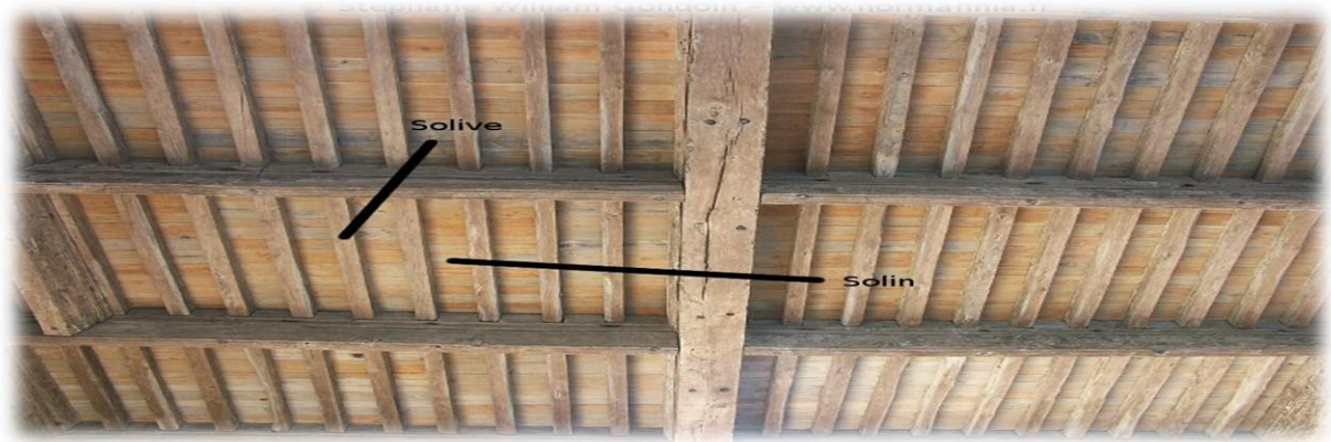
Figure I.34 : Planchers par solivage
