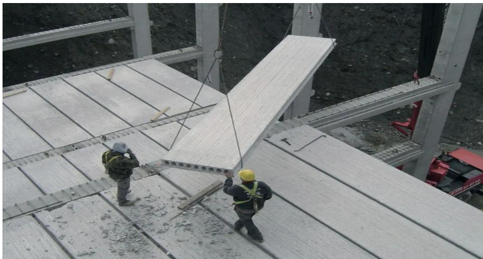
Figure I.26 : plancher dalle alvéolée
