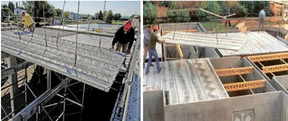
Figure I.29 : plancher à prédalles
