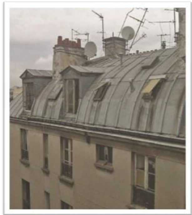
Figure 3-5: État initial toiture cintrée (source : F+L architects)
