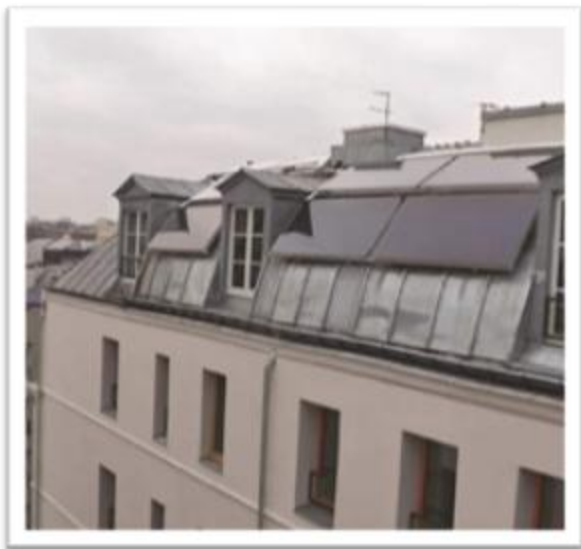
Figure 3-16: Panneaux solaires thermiques
