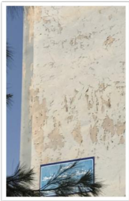
Photo 4-2: présence des taches humide
