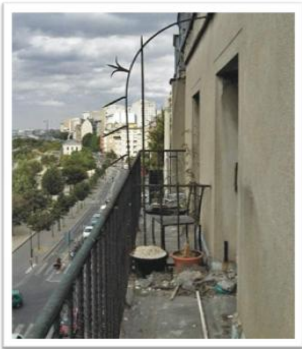
Figure 3-4: État initial balcon de la façade principale du 1 passage Goix (source:F+L architects)
