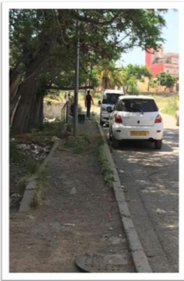
Photo 4-9: Vue sur les trottoirs non finis
