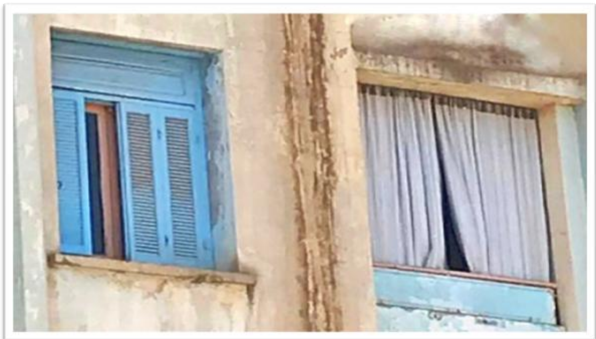
Figure 4-13 : Les fenêtres de cuisine.
