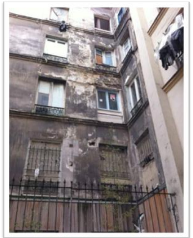
Figure 3-7: État initial façade sur cour
