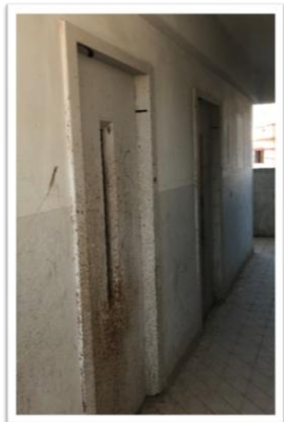
Photo 4-5: Accès à l'ascenseur
