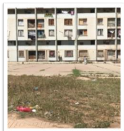
Photo 4-8: l'état catastrophique du stade
