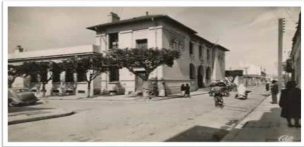
Figure 4-3: La Grande Poste d'Ain Témouchent
