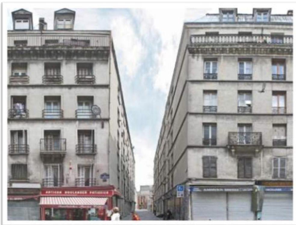
Figure 3-2: État initial vu depuis la rue d'Aubervilliers
