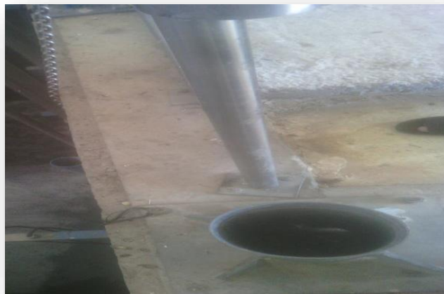
Figure 17 : déversoir d'orage (BENBOUCHTA.F.UATBB ,2021)
