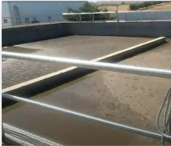
Figure 21 : bassin d'aération ( BENBOUCHTA.F.UATBB ,2021 )
