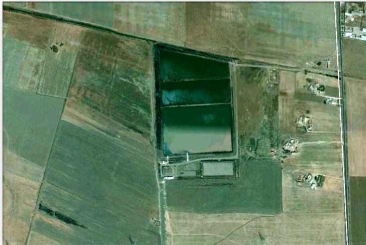
Figure 8 : station d'épuration d'Ain Larabaa (ONA, 2021).
