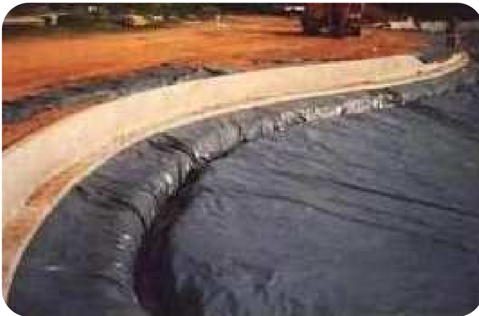
Figure 7 : Etanchéité d'un bassin géo membrane en polypropylène
