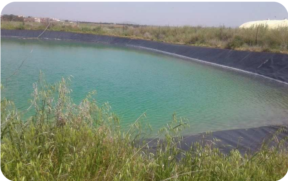
Figure 31 : Bassin géo membrane
