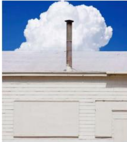
Figure II-22: la peinture isolante en extérieur [70]
