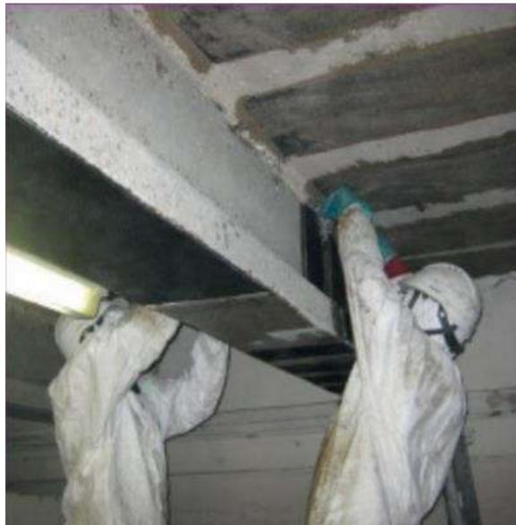
*Figure 28 : Application d'un patch composite pour le renforcement du pont.[22]*
