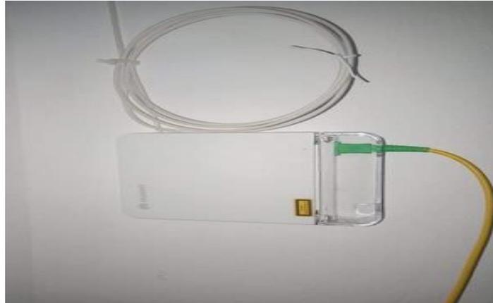
**Figure II. 9.**Prise Terminal Optique.
