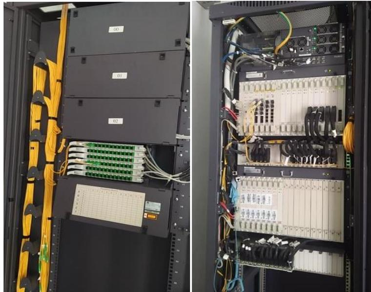
**Figure II. 4.**Nœud raccordement optique NRO.
