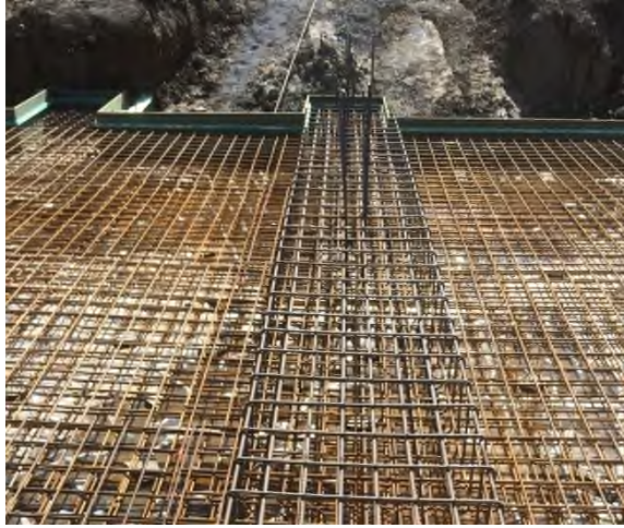
Figure VII-4 : Ferrailage du radier.
