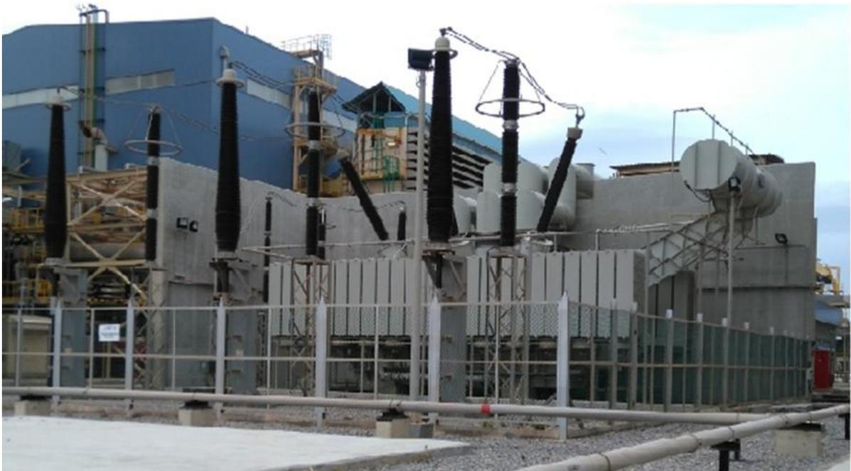
**Figure I-8 :** Transformateur Principal Elévateur.
