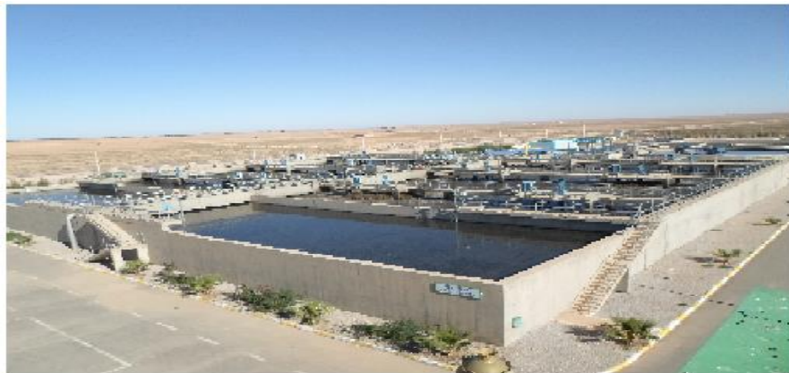
Figure I-9 : Photo - Bassin Biologique – Décanteur – Epaisseur – Déshydratation
