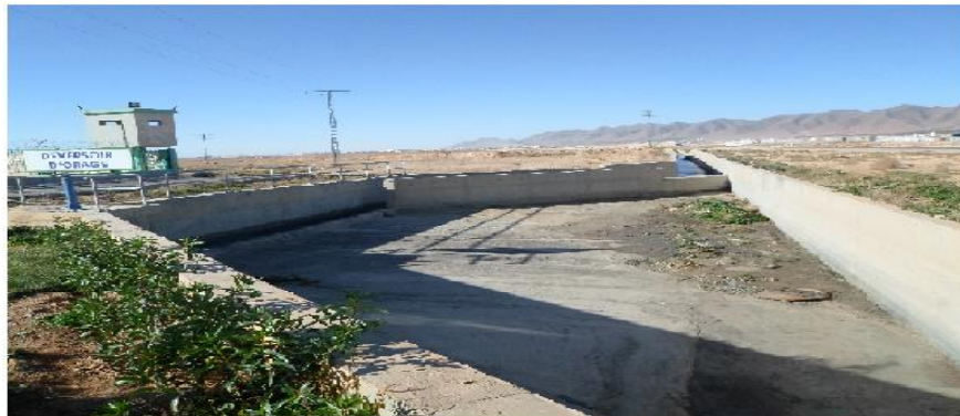
Figure I-7 : Photo - Déversoir D'Orage
