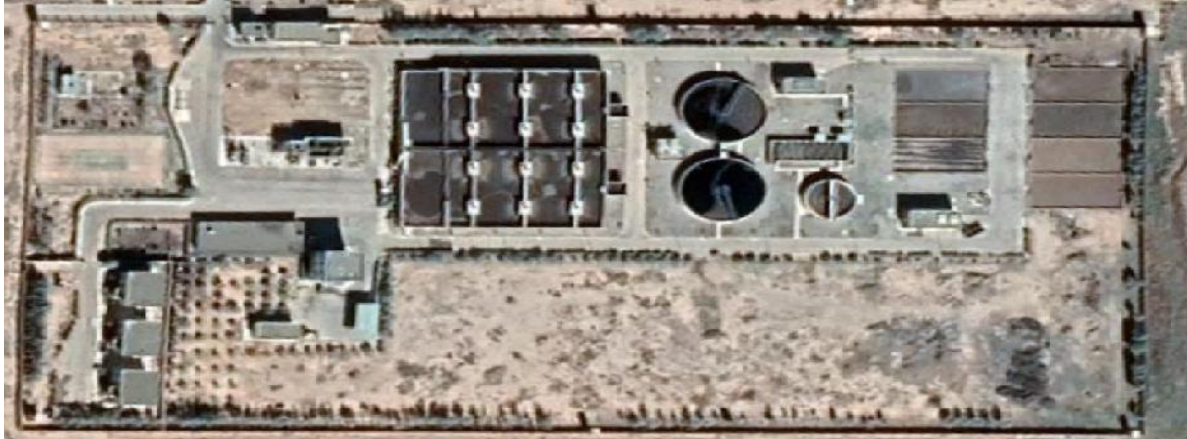
Figure I-6 : Station d'épuration de Mécheria
