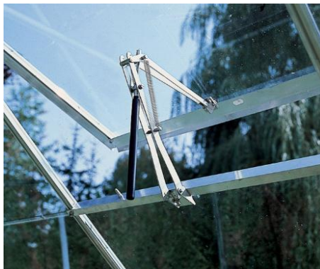
Figure III. 18: Vérin de la serre du LINS
