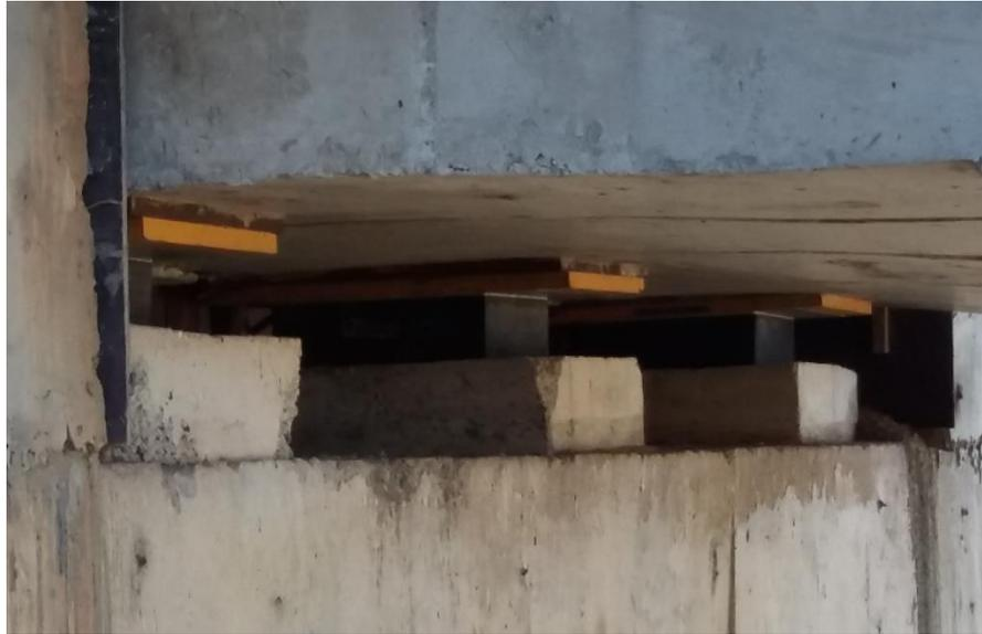
Figure 141: Appareil d'appui en élastomère fretté
