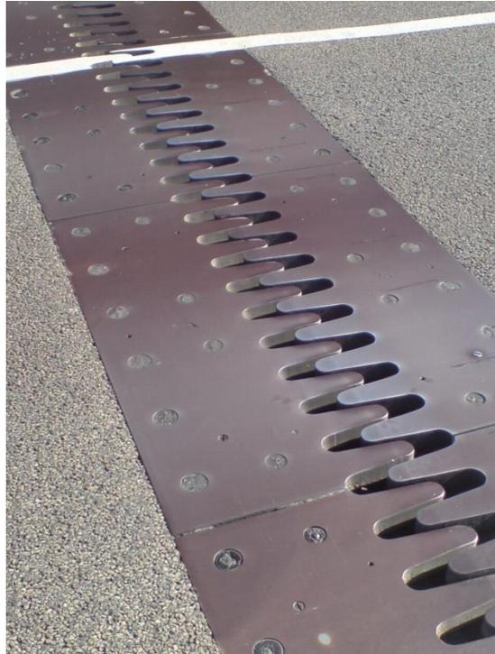
**Figure 140:** Joint de chaussée
