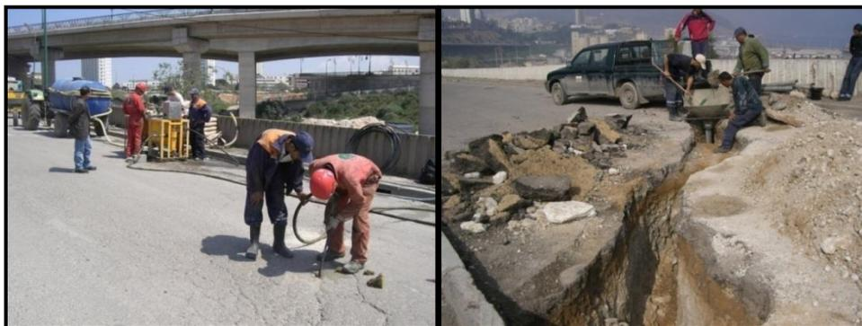
**Fig. 4.3 Injection de coulis par le forage Fig. 4.4 Remplissage au béton à grave concassée**
