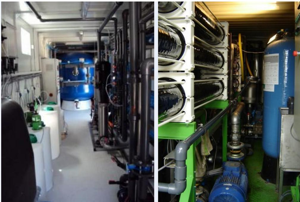
**Fig. 4.12** Systèmes d'osmose inverse containerisés
