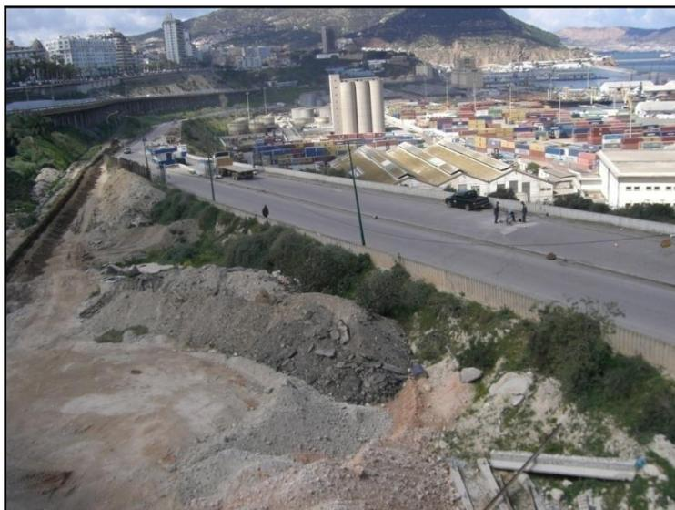
**Fig. 3 L'ancien exutoire de ce ravin est compris entre le pont Zabana et les terre pleins portuaires. Il se trouve actuellement remblayé par les travaux de réalisation de la route COUTANT.**
