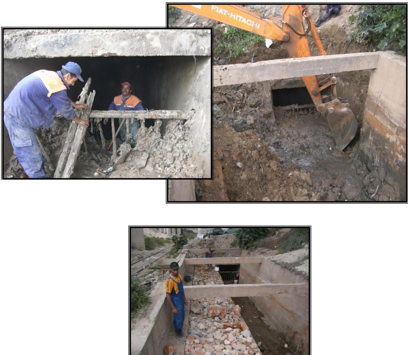
**Fig. 4.2 Curage des canaux latéraux à la voie des chemins de fer :**
