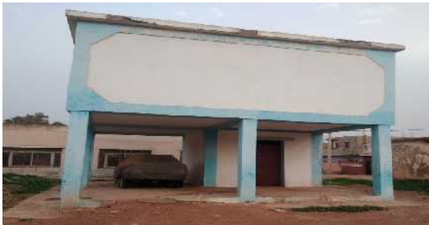
_FIGURE 11 : CHATEAU D'EAU EXISTANT 100 M3
