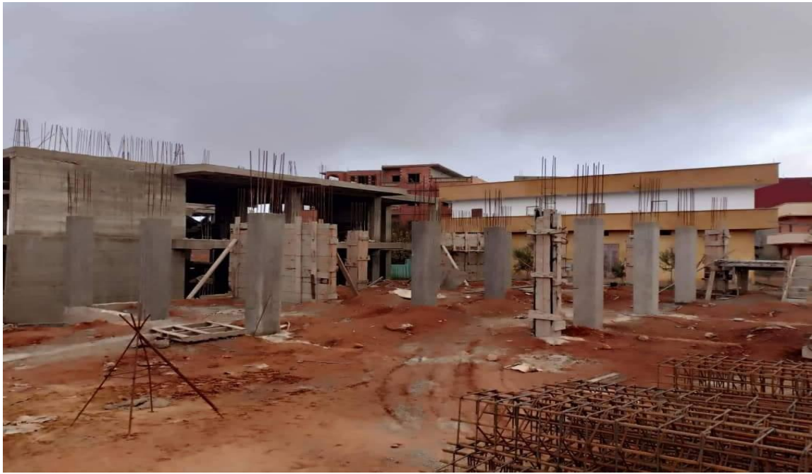
Figure 13 : poteaux et voiles
