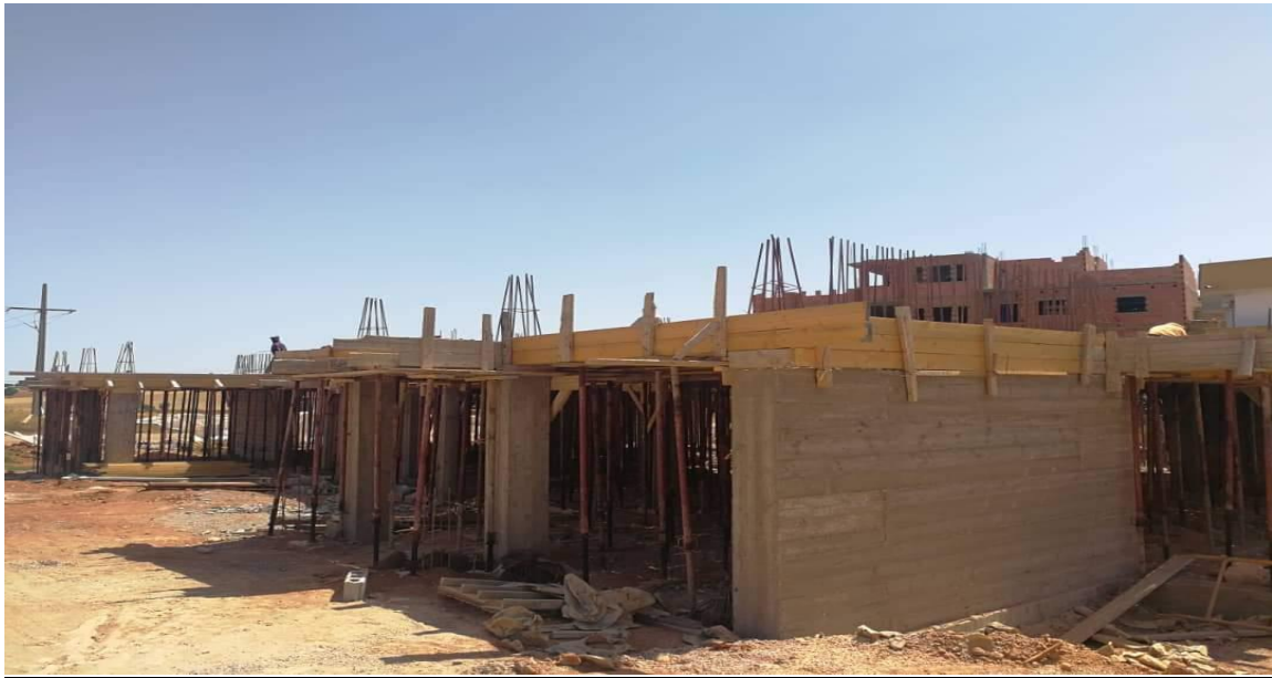
Figure 17 : plancher RDS +voiles
