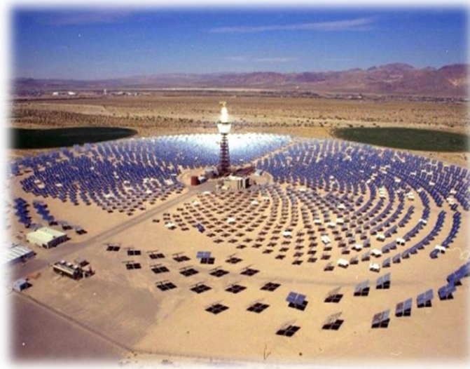
Figure II.4 : Centrale de l'énergie solaire.
