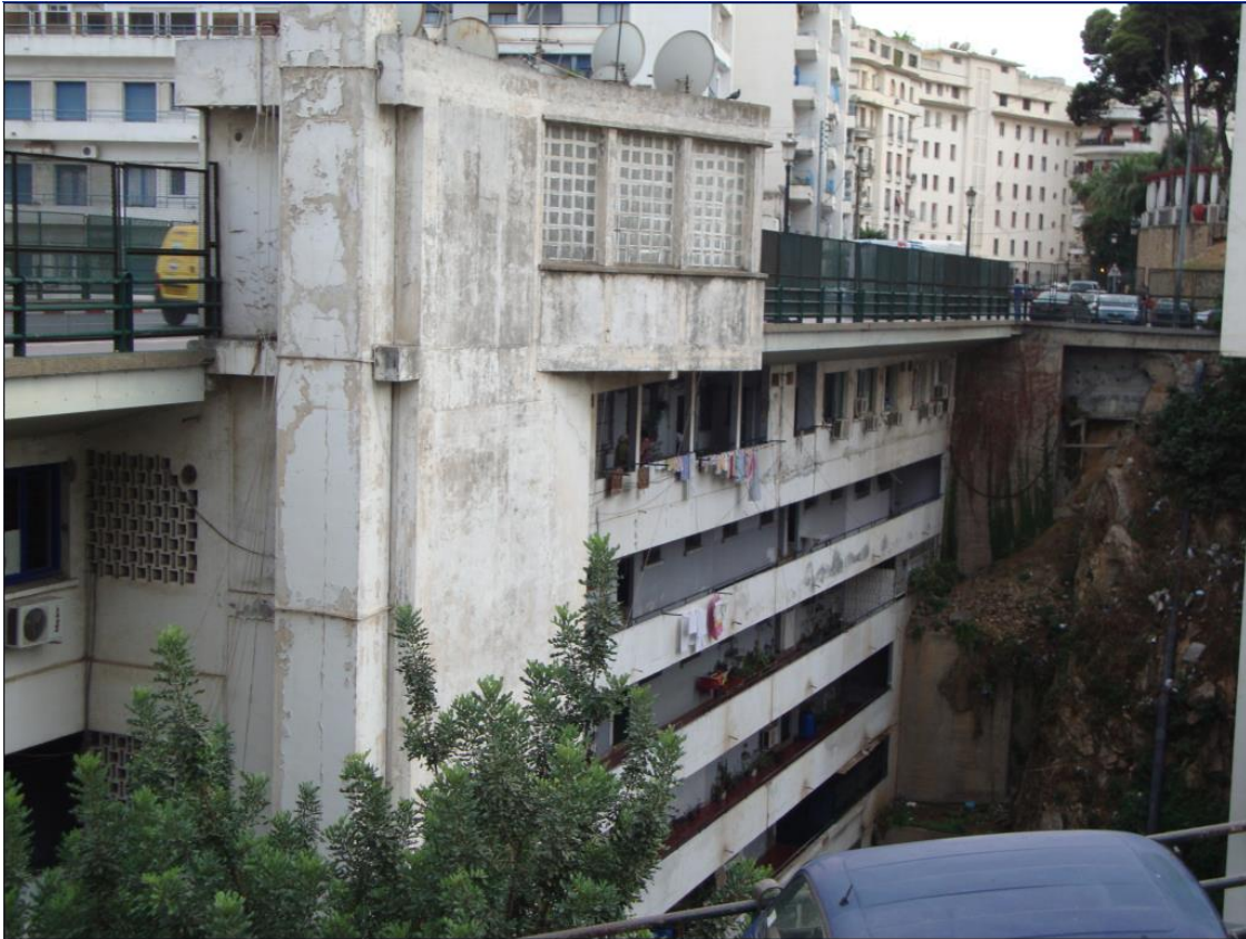
Figure 1.4:Projet immeuble-pont (phase exploitation 2018)
