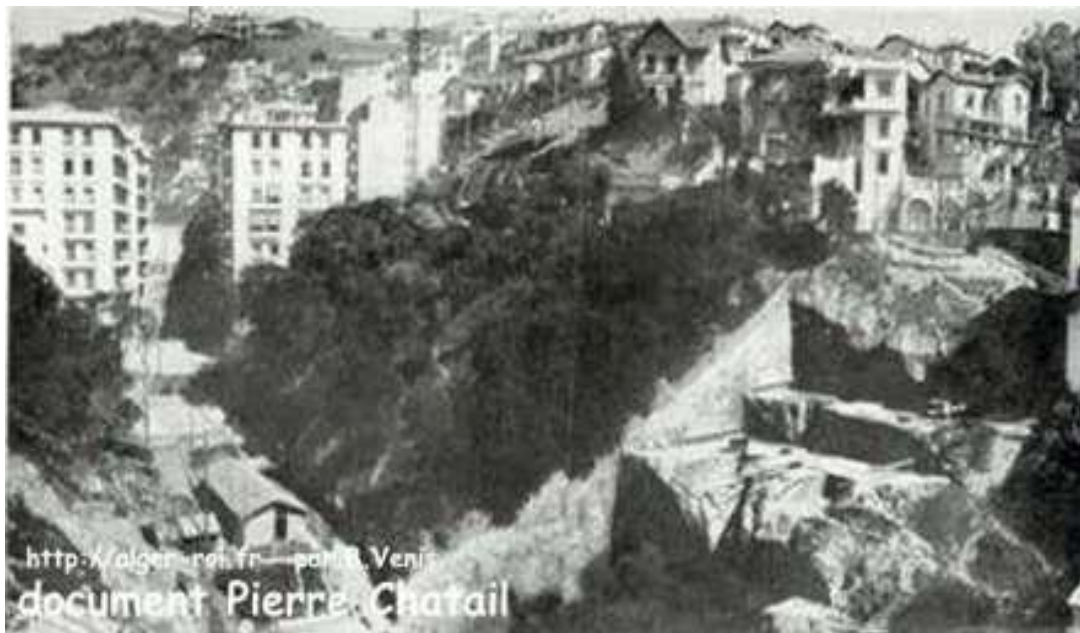
Figure 1.2 :site du projet immeuble-pont (avant la réalisation)
