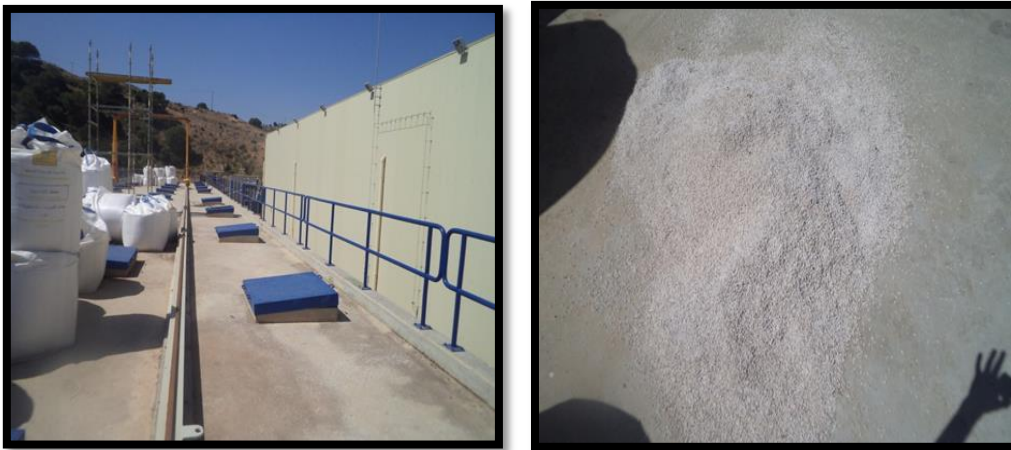
Photo 8 : Les chambres de l'eau produite et la calcite.
