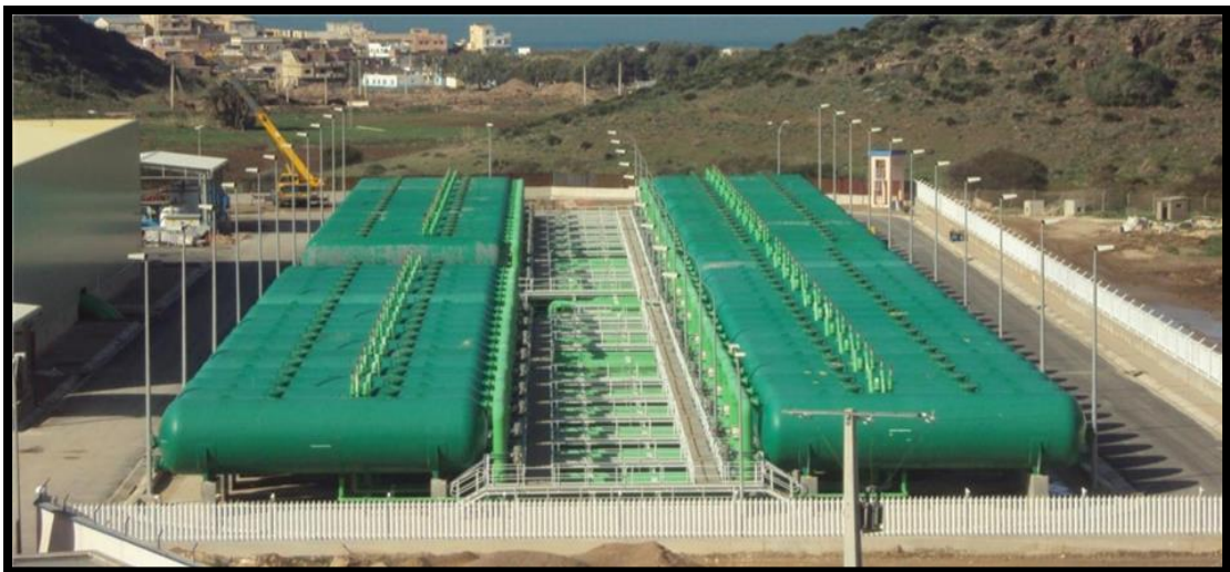
« Photo 3 » : Zone des filtres à sable et à anthracite de la SDEM de Béni Saf.
