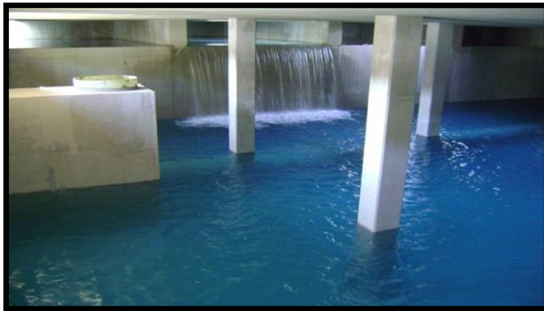
Photo 9 : Bâtiment d'eau produite.
