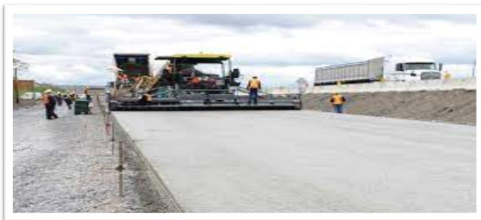
Figure II-5 : mise en place du BCR
