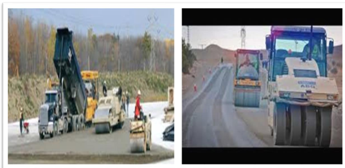
Figure II 1: Equipement du compactage du BCR.
