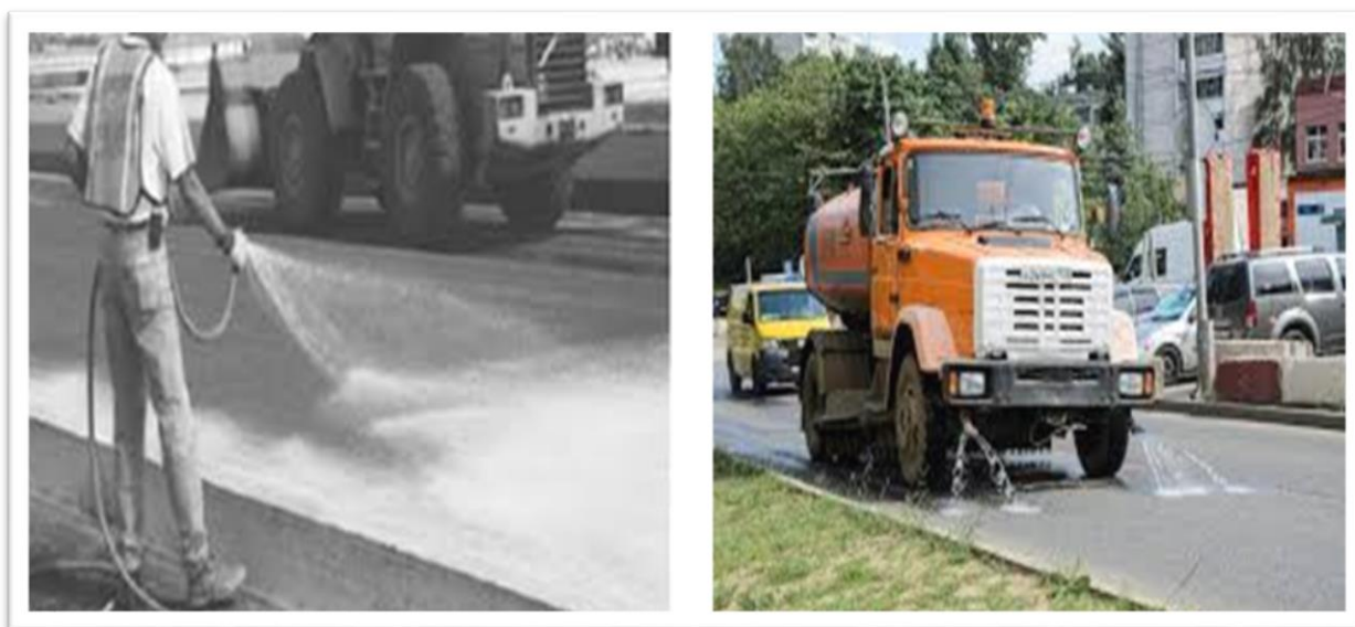
Figure II-6 : Cure du béton par arrosages ciblés.
