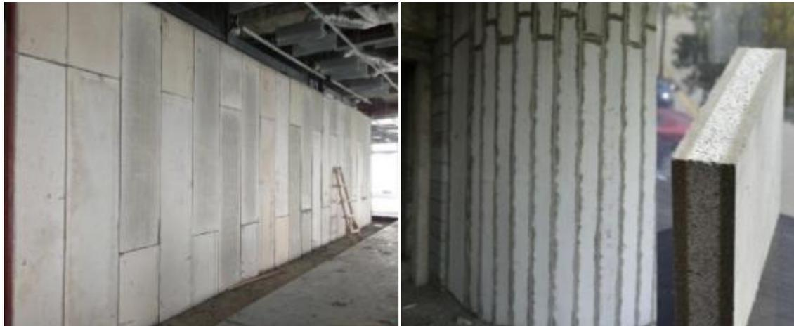
Figure 36:Quelque application de béton polymère (isolation phonique). [3]
