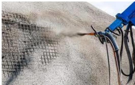
Figure 13: Béton projeté.[3]
