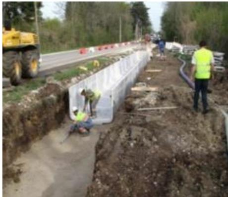
Figure 34: Quelques applications du béton polymères (drainage et hydrauliques). [3]
