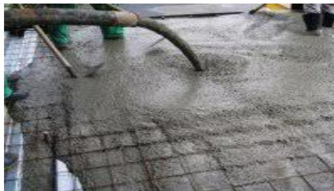
Figure 12:Le béton auto-plaçant [3]
