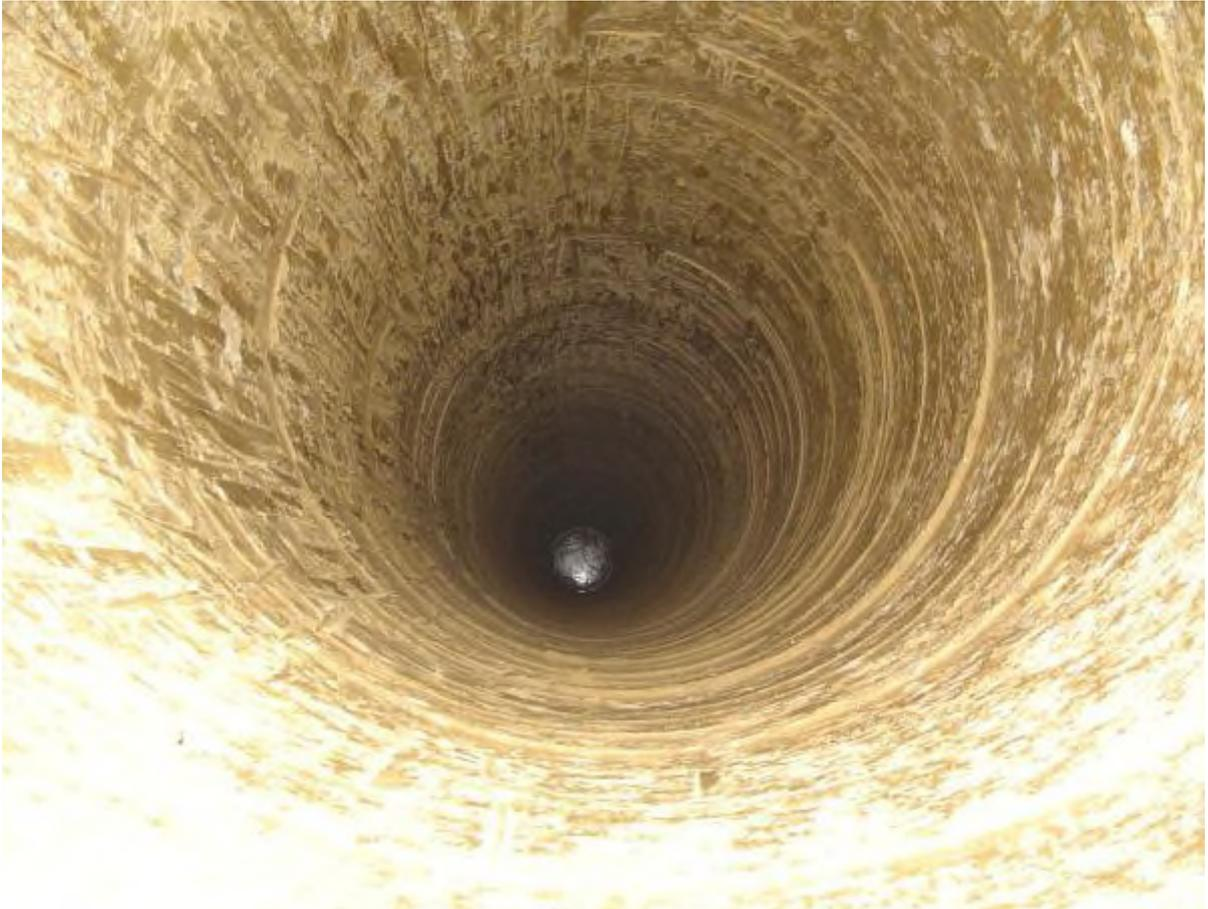
Figure03 : Trou de forage réalisé au battage
