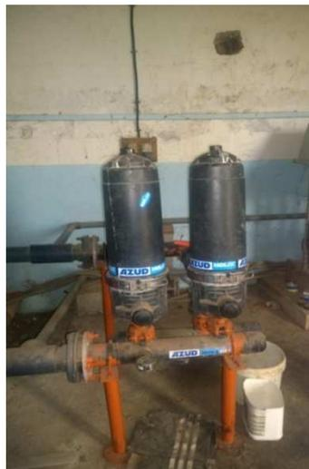
**Figure 11:** Filtre à disque
