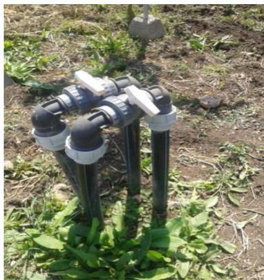
**Figure 26:** Vannes de sectionnement
