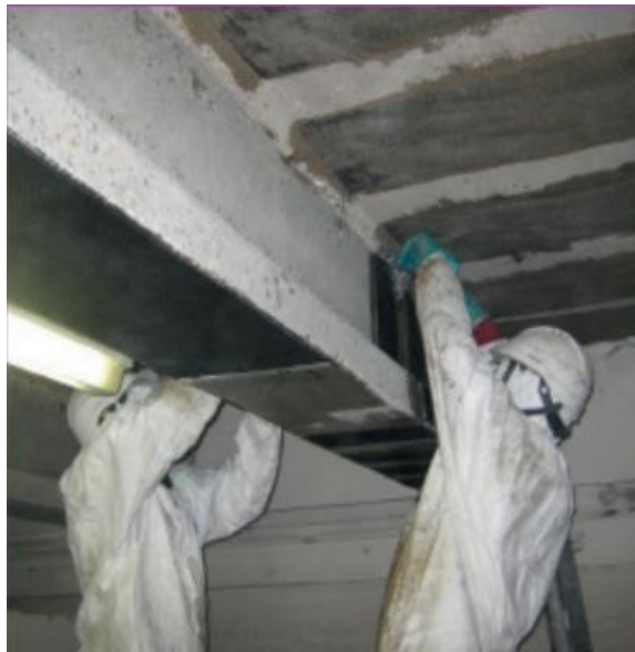
Figure 28 : Application d'un patch composite pour le renforcement du pont.[22]
