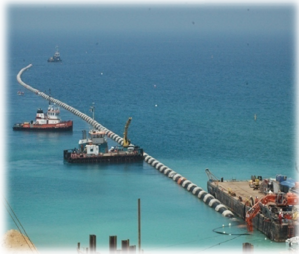
Figure III-5 Installation des conduites
