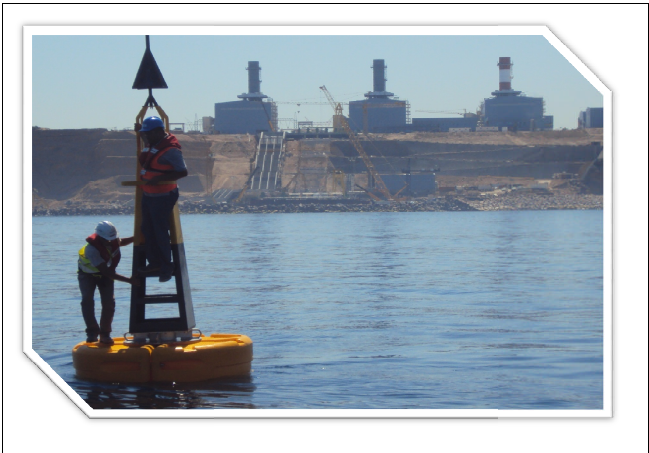
Figure III-14 Mise en place de la bouée de signalisation maritime
