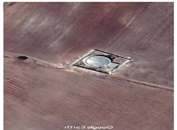
Figure 24: Réservoir 2000 m3 sur Google EARTH
