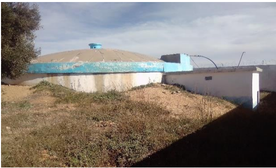
Figure 22: Réservoir 500 m3
