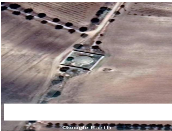
Figure 25: réservoir 500 m3 sur Google EARTH
