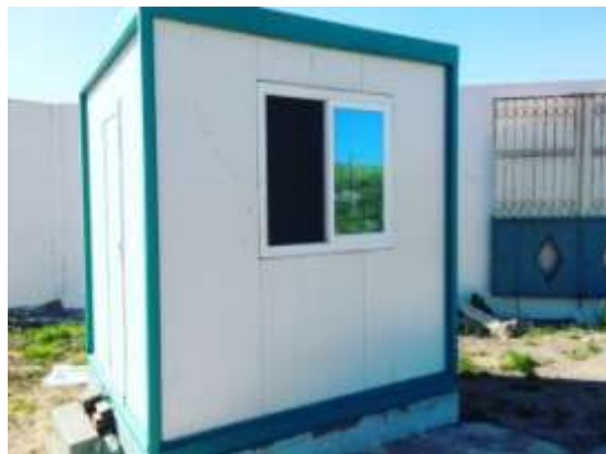
Figure N°25 : Le poste de garde.
