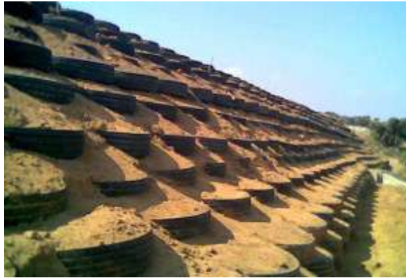
Figure N° 65 : Un mur de soutènement « pneusol »
