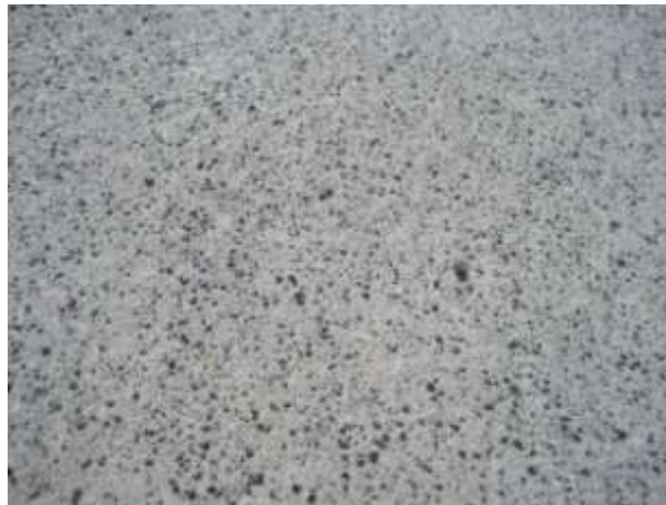
Figure N°62 : l'utilisation des granulats des pneus dans le béton.
