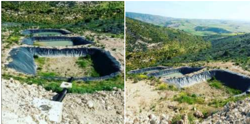
Figure N°18 : Les bassins de lixiviats
