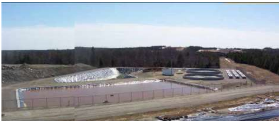
Figure N° 4 : Station de traitement de lixiviat.
