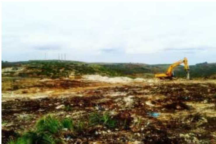
Figure N°22 : Les Travaux d'excavation de site
