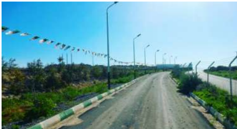
Figure N°31 : La voie d'accès.
