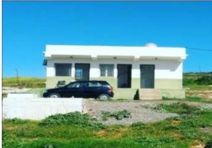
Figure N°26 : Le bloc administratif.
