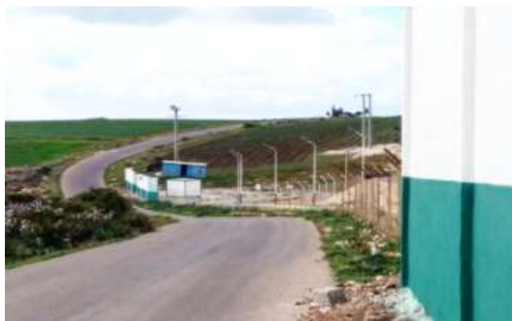
Figure N°32 : L'éclairage extérieur de la décharge.
