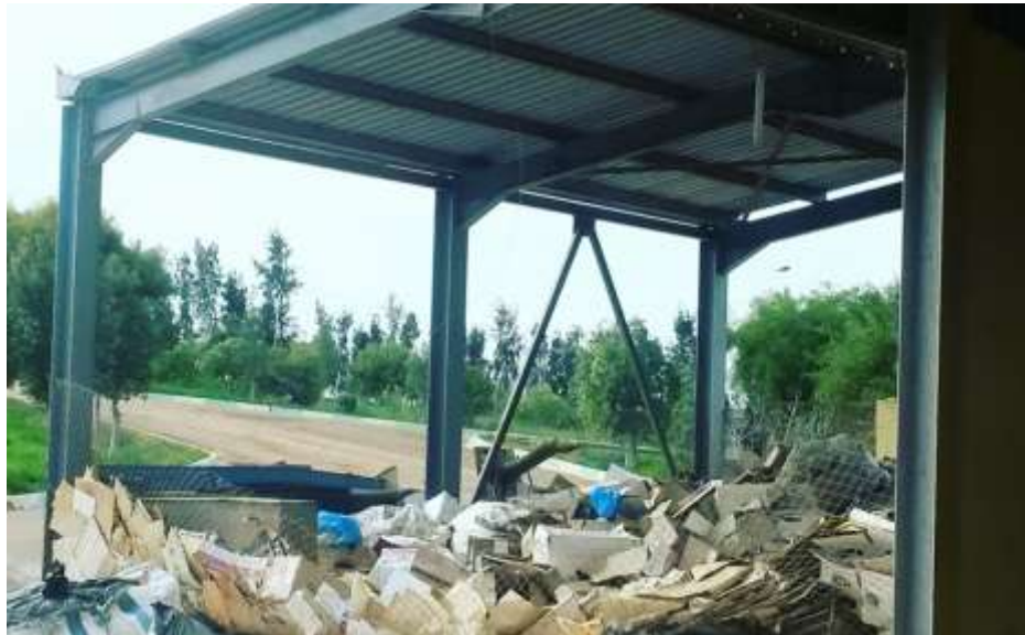
Figure N°48 : Centre de tri du carton à Sidi Ben Adda.
