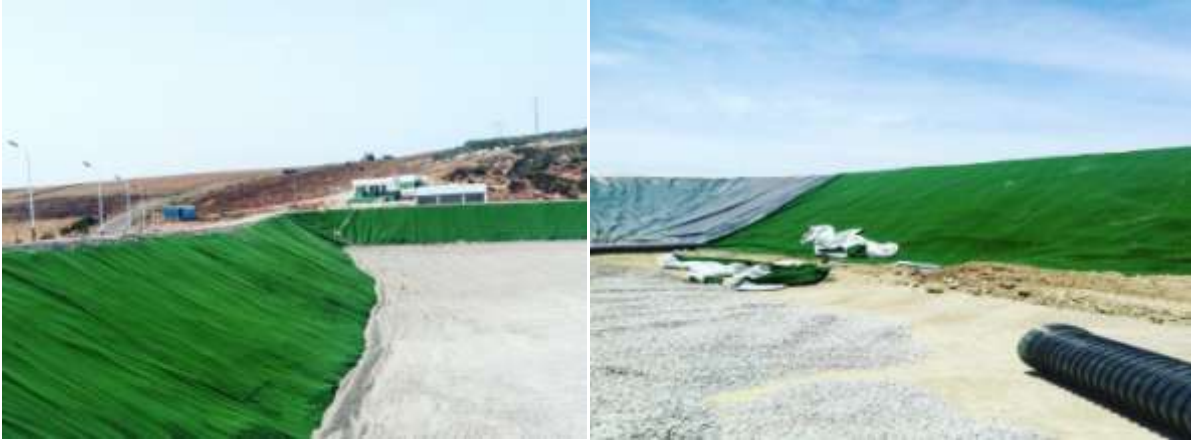
Figure N° 35 : Raccordement en pied de talus.
