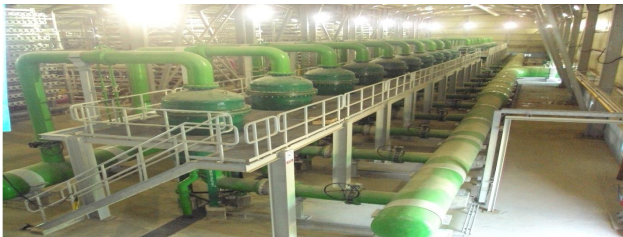
« Photo III.5 » : les filtres à cartouches de la SDEM de Béni Saf
