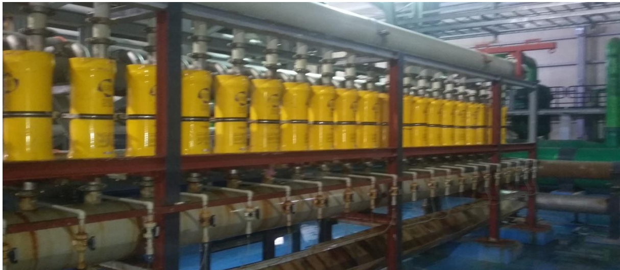
« Photo III.7 » : les récupérateurs d'énergie (ERI) d'un module d'OI de le SDEM
