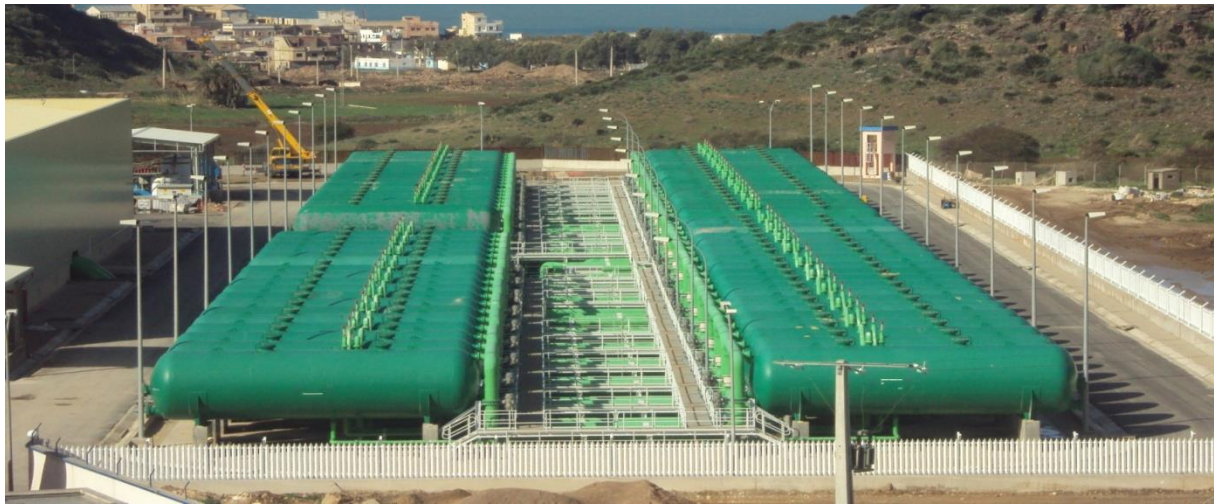
« Photo III.4 » : zone des filtres à sable et à anthracite de la SDEM de Béni Saf
