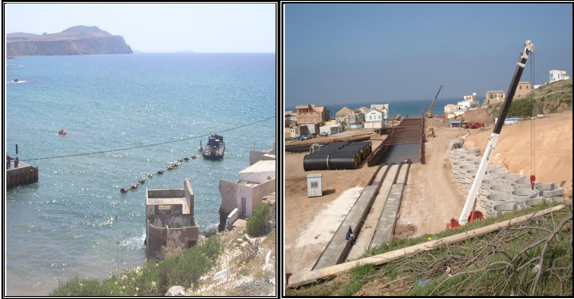
« Photo III.1 » : la conduite de captage en période de la construction.
