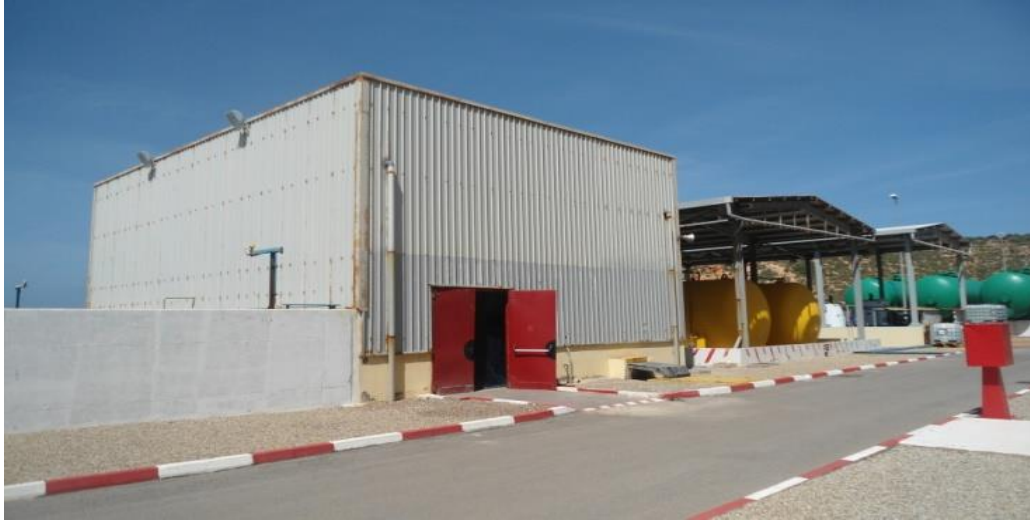
« Photo III.10 » : bâtiment de lavage des filtres
