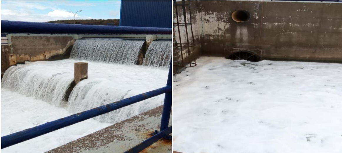
«Photo III.11 » : le bassin de saumure de la SDEM de Béni Saf
