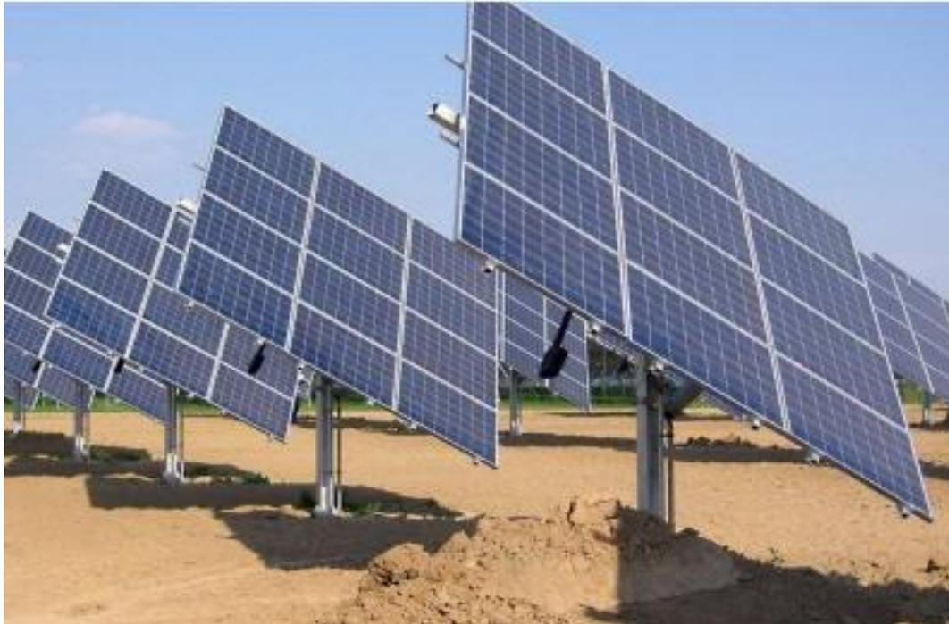
**Figure II.3 :** Suiveur solaire automatique.
