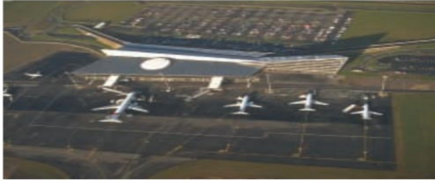
Figure I.4 : Aire de stationnement.
