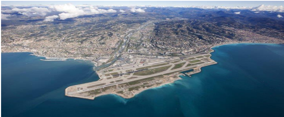
Figure I.1 : Vue aérienne de l'aéroport de Nice.
