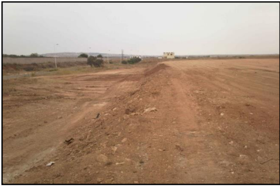
Figure V.13 : crevasse 4 après remblaiement.
