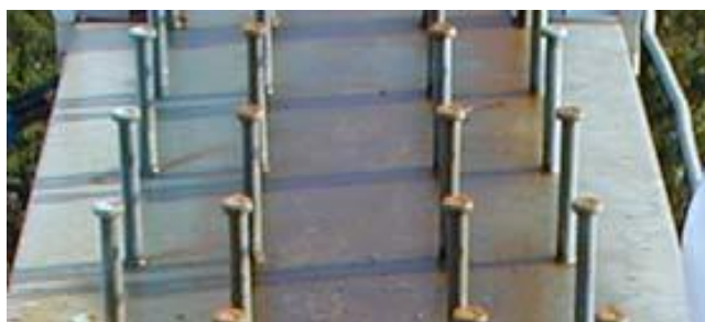
Figure 9: Files de goujons soudés sur la semelle supérieure d'une poutre
