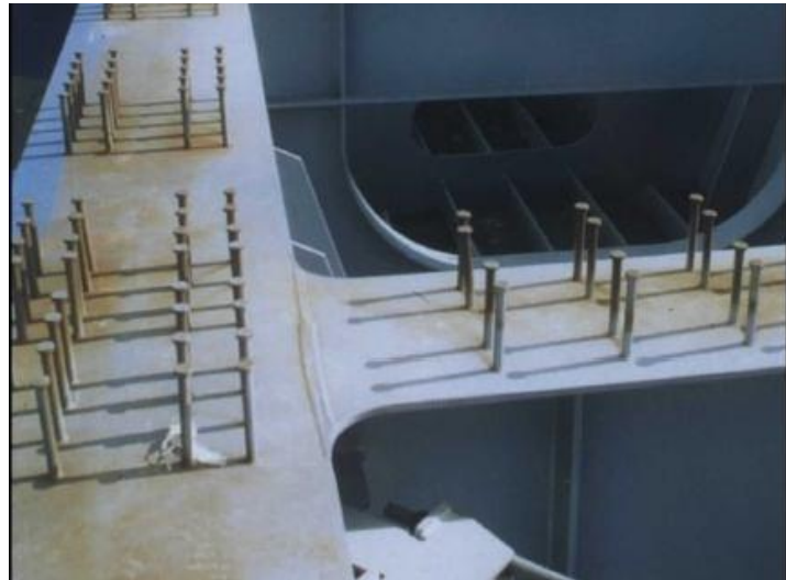
Figure 21 : Connecteurs de type goujons
