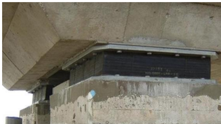
Figure 13 : Photo réelle d'un appareil d'appuis
