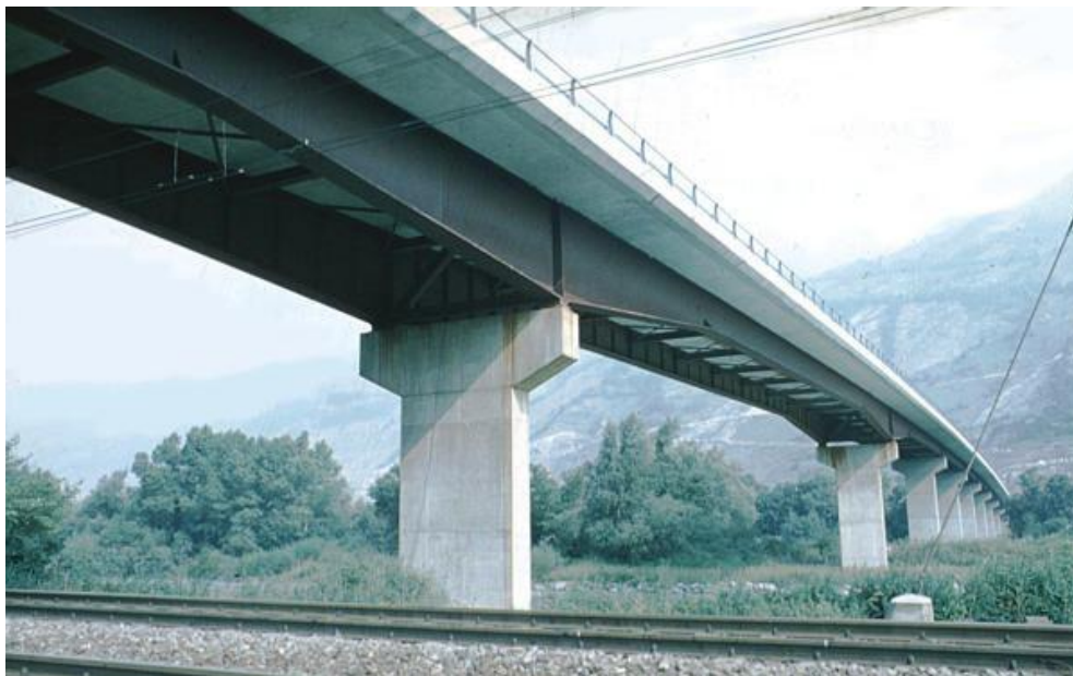
Figure 5 : Un exemple de pont mixte bipoutre
