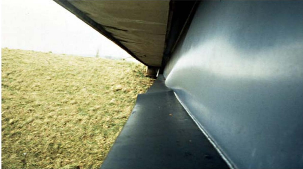
Figure 19: Photo représentative de voilement
