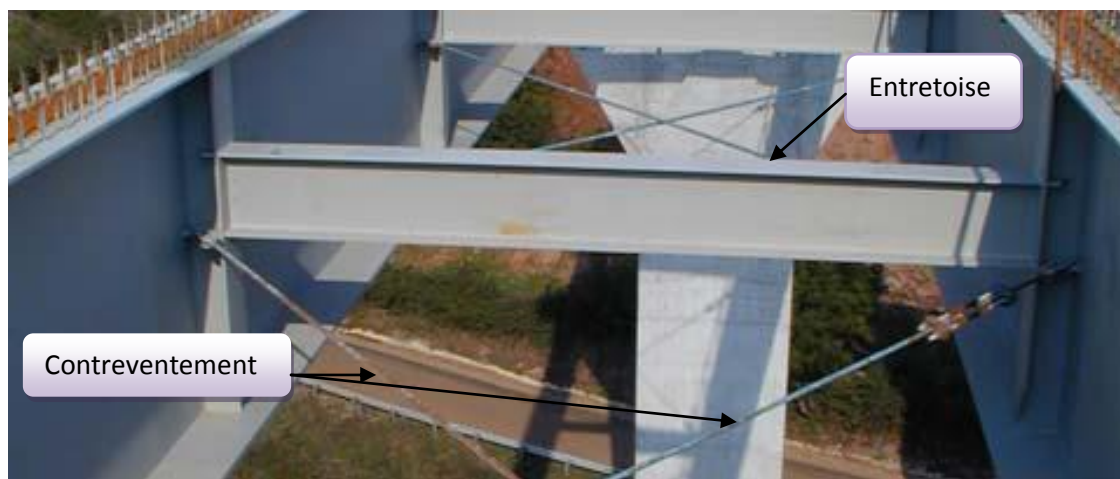
Figure 10: Ossature à entretoises.
