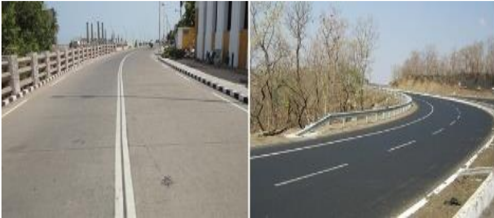
Fig. V .1: Chaussée rigide et chaussée souple
