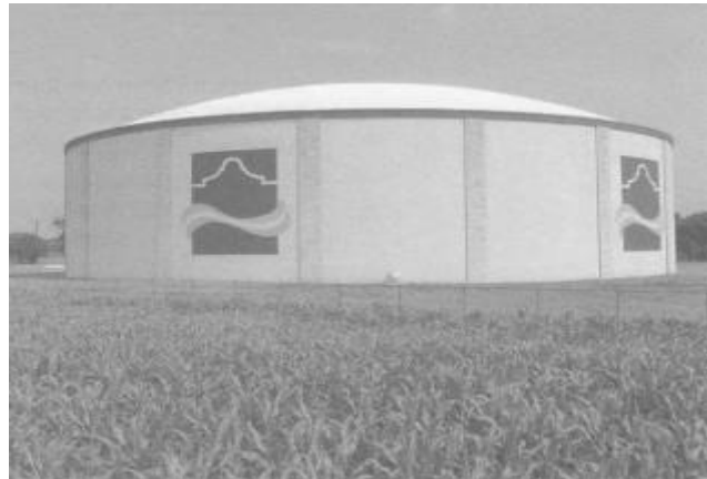
Figure 2 : Réservoir d'eau en béton bobiné Cauftesy AF Prelaad Inc [1]
