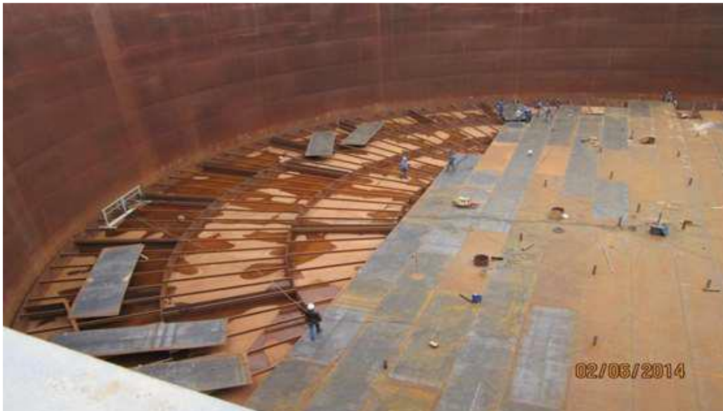
Figure 31: Montage du toit flottant [5]
