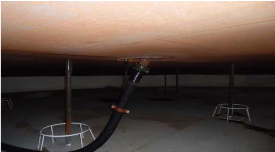
Figure 32 : Drainage des eaux pluviales [5]
