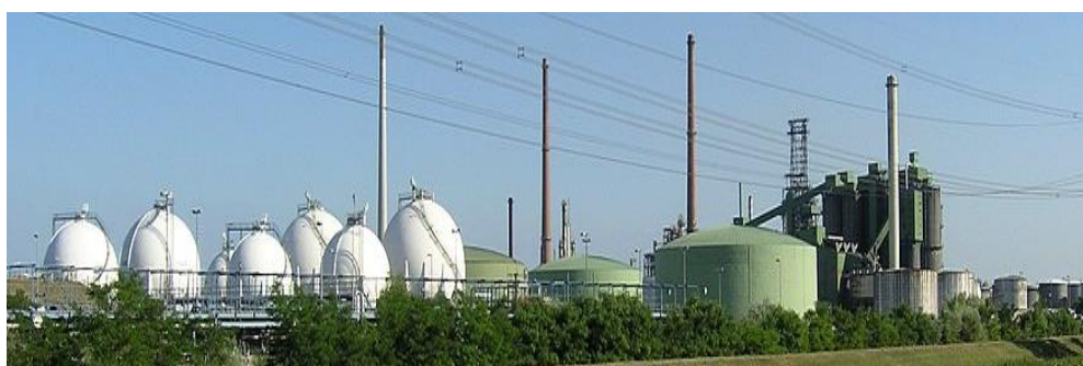
Figure 13: Parc de stockage de la raffinerie MiRO à Karlsruhe, en Allemagne, avec des réservoirs de forme différente pour les produits pétroliers gazeux (gaz de pétrole liquéfié), liquides (essence ou fioul) et solides (coke de pétrole).[4]
