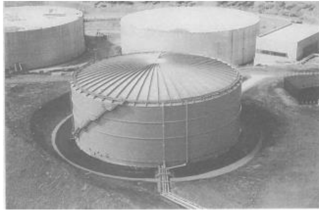
Figure 3: Un réservoir d'eau de 45 m de diamètre Conseil de Whessoe [1]
