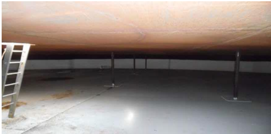
Figure 34 : Revêtement par la résine [5]
