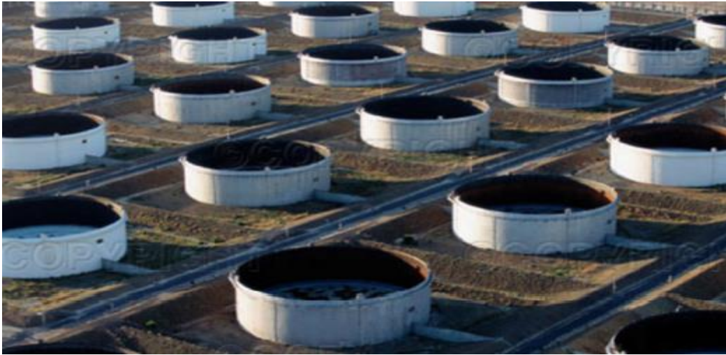
Figure 10: Bacs à toit flottant [2]
