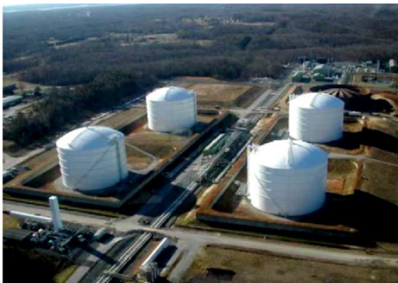
Figure 25: Les réservoirs à simple intégrité – Couve Point aux USA. [5]
