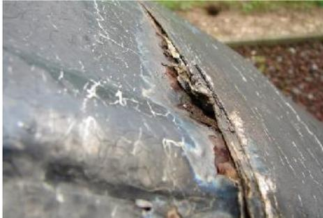
*Figure II-12: La corrosion due au recouvrement sur les joints.[10]*
