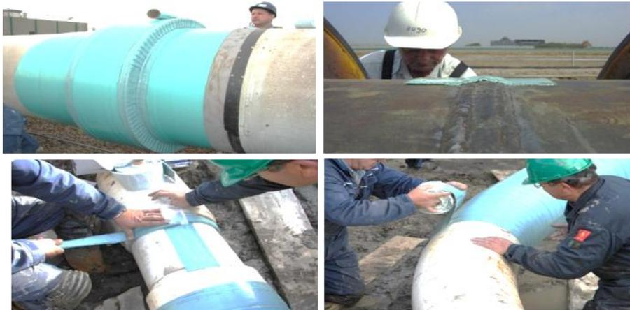
*Figure II-18: les opérations nécessaire pour éliminer la corrosion[11]*
