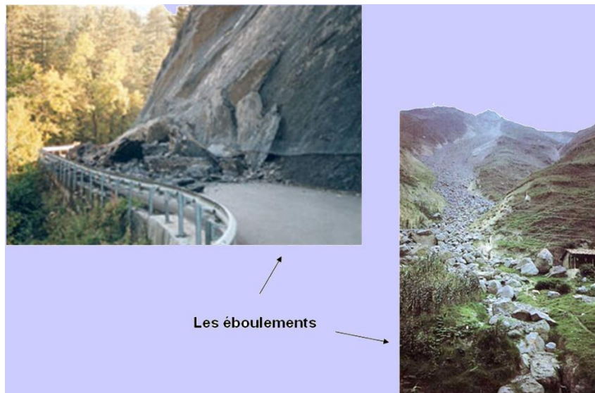
Photo 12. Les éboulements (MazourM., 2004)
