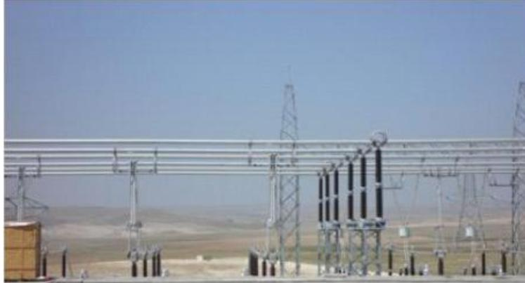
*Fig II-17 Jeux de barres de poste 400 KV*
