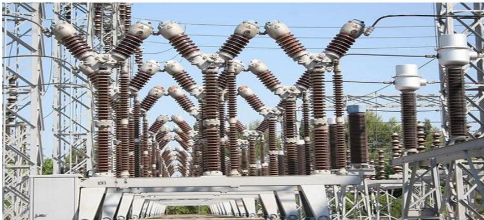
*Fig II-19 poste électrique isolée par l'air AIS*
