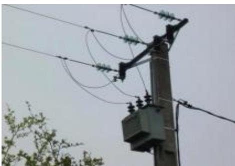
*Fig II-1 Poste de distribution sur support*
